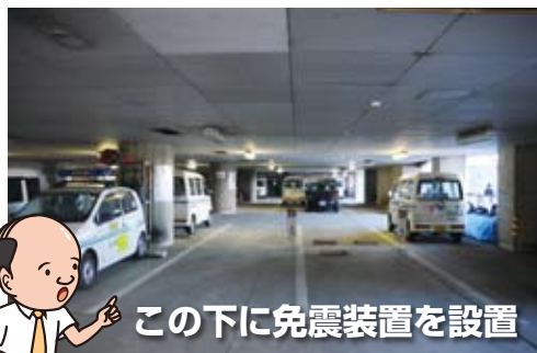
日野市役所本庁舎地下駐車場
