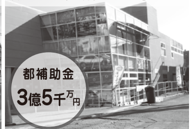
障害者施設「工房夢ふうせん」建設
